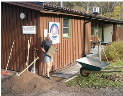
Frank i färd med att tillsammans med Kent lägga i ordning plattorna framför stugan. Kent var vid fototillfället sysselsatt bakom stugan.
